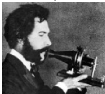
le téléphone est sans numérotation ses principaux matériaux : Corps en bois, fil électrique en cuivre recouvert d'une tresse en coton. Il permet la liaison entre deux correspondants 1876
