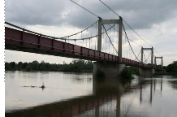
Pont suspendu de Bonny-sur-Loire Construit en 1899-1902 Pont en Acier Département Loiret
