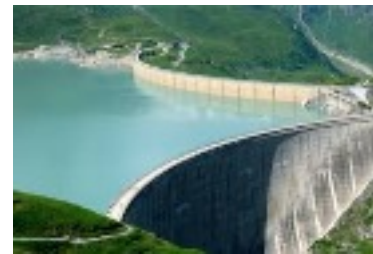
le barrage hydroélectrique met à profit l'énergie de l'eau
