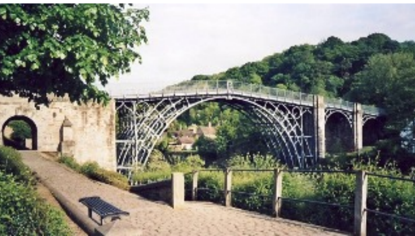
Coalbrookdale Iron Bridge [GB] Les Ponts Métallique Pont en Arc Voute Matériaux:Métal fonte
