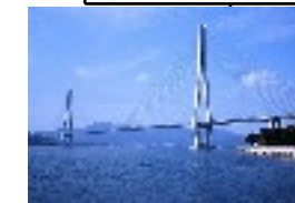
Pont de Tatarskiy[Japon] Les Ponts à Hauban Matériaux:Béton Armé
