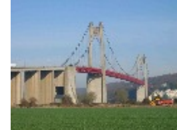
Pont de Tancarville [F] Les Ponts Suspendu Matériaux:Béton et Acier
