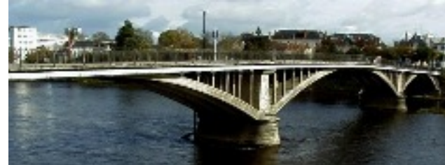
Pont Camille de HOGUES Châtelleraut [F] Pont en Arc Les Ponts en Béton Matériaux:Béton Armé
